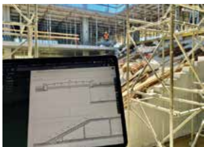
VOLUM3 omogućuje svima na gradilištu suradnju i pristup projektima s bilo kojeg uređaja
